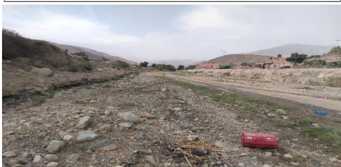
FIGURA N°02: TRAMO DE LA QUEBRADA SOCOS (MACAS), QUE SE ENCUNETRA COLMATADO EN SU CAUCE.
